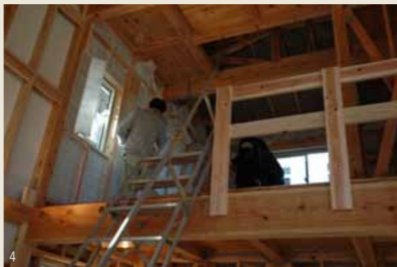
モデルハウスの構造見学会の様子。会場では、主に住宅の性能に関する建材の説明会や断熱材の施工実演などが行われた。構造に使用されている「紀州杉・檜」の製造元である山長商店の榎本副社長自らが製品説明する場面も
