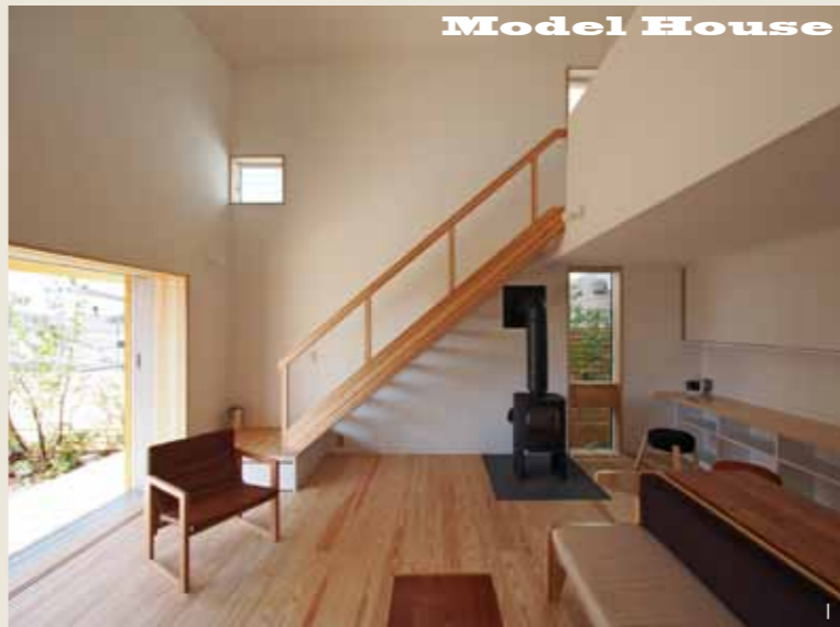
2013年3月に完成したモデルハウス(設計:伊礼智設計室)のリビング。フローリングと同じ紀州杉で製作した階段が吹抜け空間によく映える
