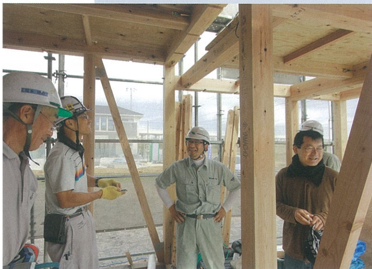
現場では、慣れない納まりや初めて使う材料に戸惑うこともあったが、1つ1つ学んで自社の技術として取り入れた
